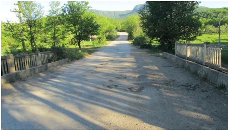
Рисунок 100. Мост через реку Бельбек
