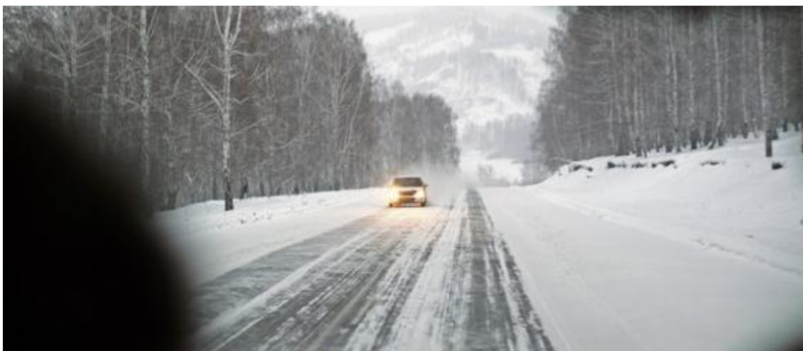
Фото 1.2. Состояние дороги Миасса-Карабаш
